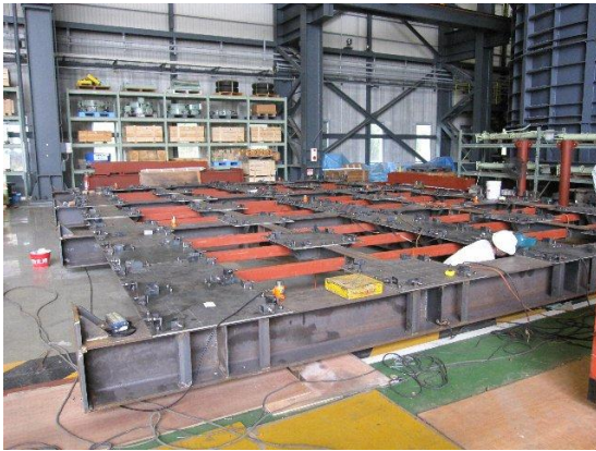
鉄骨架台組立
