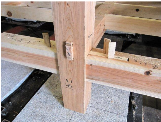
1 階隅柱足固め接合部
