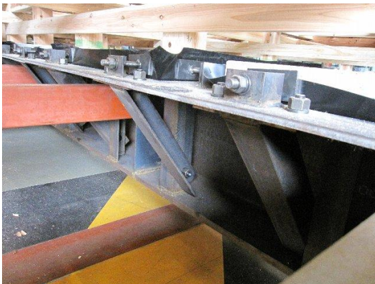
鉄骨架台礎石下頬杖
