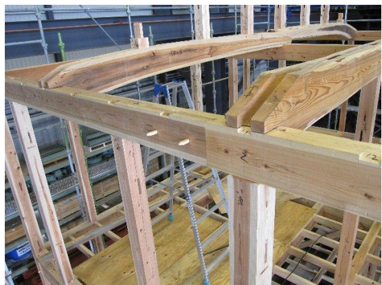
小屋裏接合部
