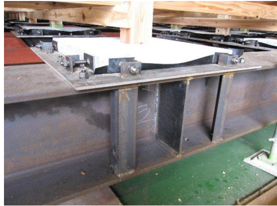
鉄骨架台礎石下補強リブ
