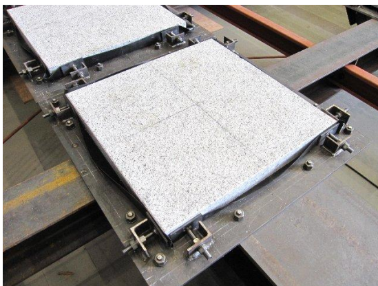
礎石固定および位置出し
