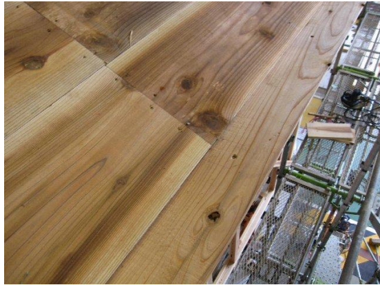
野地板留め付け
