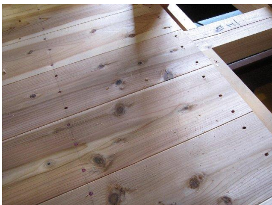
床板留め付け
